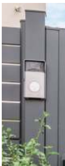
Poteau 180x180 à sceller et remplir de béton
